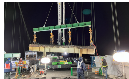
①既設桁撤去状況
